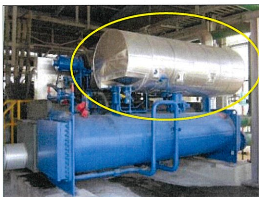
ภาพที่ 2.2-9 อุปกรณ์ลดเสียงจากแหล่งกำเนิด (บริเวณ MRU)
