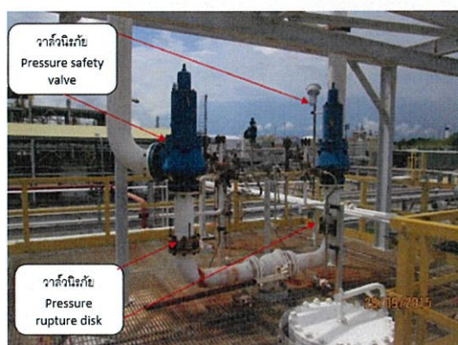
วาล์วนิรภัย และอุปกรณ์ระบายความดัน (Rupture Disc) ป้องกันระบบถึงปฏิกิริยา
