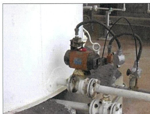
วาล์วตัดแยกระบบในกรณีฉุกเฉิน (Emergency Block Valve)
